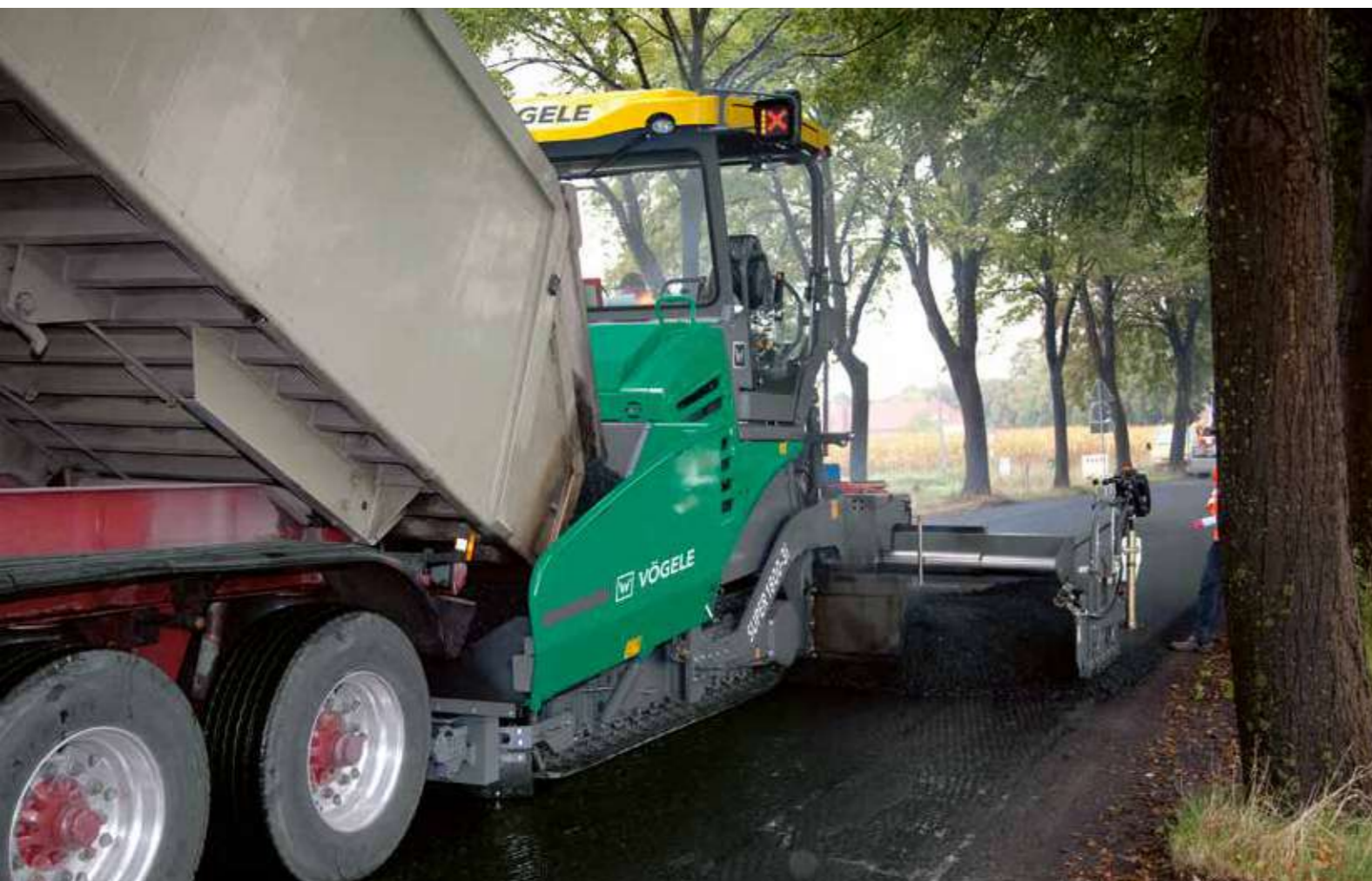
Подрессоренные упорные ролики PaveDock надежно амортизируют все удары самосвалов.
