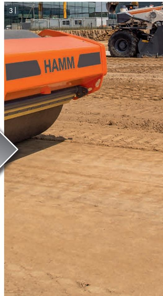
1 - 4 | В процессе укрепления грунта недостаточно прочный грунт превращается в пригодное для строительства, уплотнённое основание.
