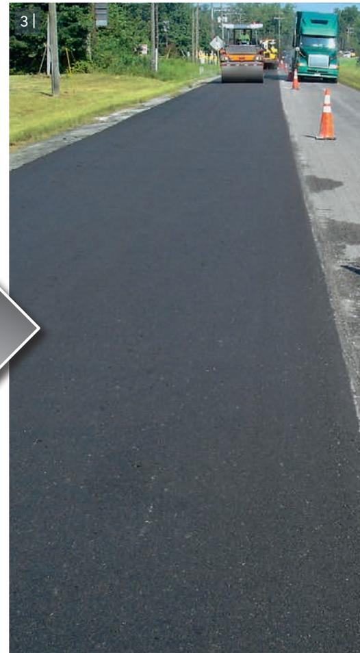
1 - 4 | Холодный ресайклинг предусматривает измельчение (гранулирование) повреждённых слоёв асфальтобетонного покрытия, добавление в полученную смесь вяжущего, перемешивание и уплотнение смеси, и её последующую укладку.
