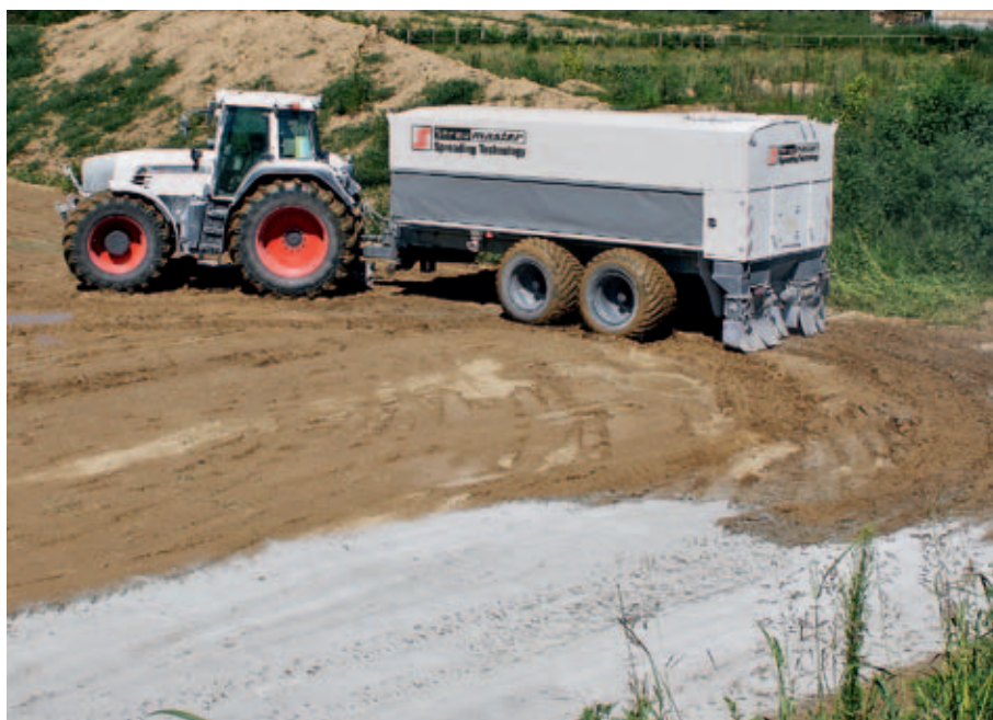
▲ SW 16 TC: Стабилизация грунта цементом для устройства промышленной зоны
