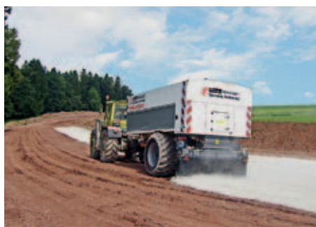
▲ SW 10 TA: Распределение извести при строительстве обьездной дороги
